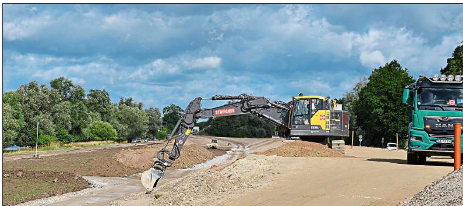
Baggerarbeiten am neuen Deich Metten-Ost: Der Schutzwall verläuft nun direkt an der Staatsstraße, der alte (links) wurde bereits abgetragen. Durch die Rückverlegung entsteht mehr Vorland, das der Donau bei Hochwasser mehr Platz lässt. – Fotos: Wendelin Trs
